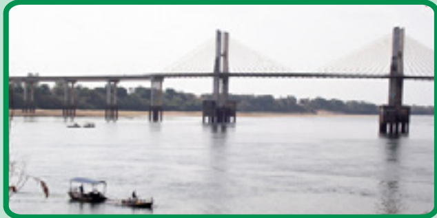
Atividade de extração de areia no rio Tocantins.
