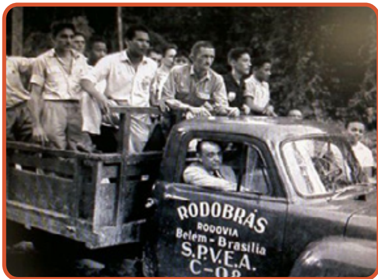
JK em visita às obras da rodovia Belém-Brasília em 1959.
